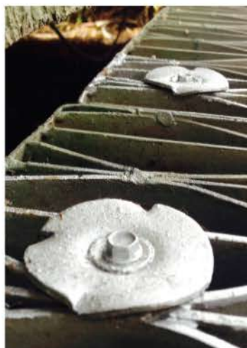
FIJACIÓN PARA LA INSTALACIÓN CON ARANDELA DE SUJECIÓN
